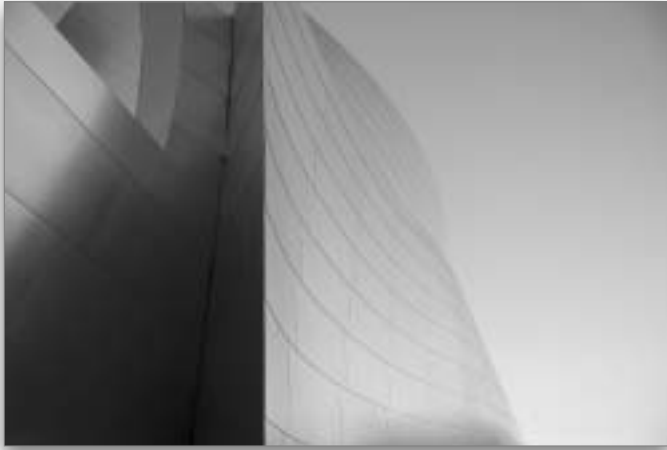
Исходный снимок (небо, верхний левый край и правая часть здания слишком светлые, а тени в левой части здания слишком темные)
